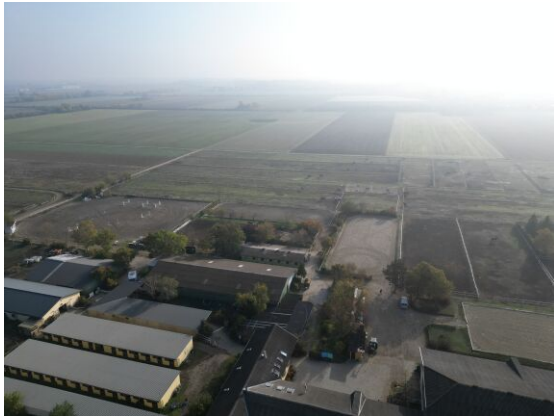
Anlage von oben
