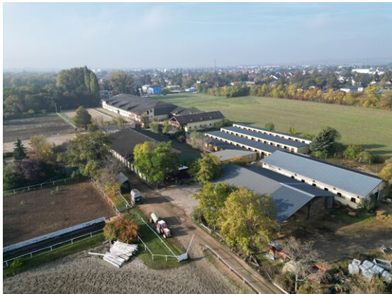
Anlage von oben 2
