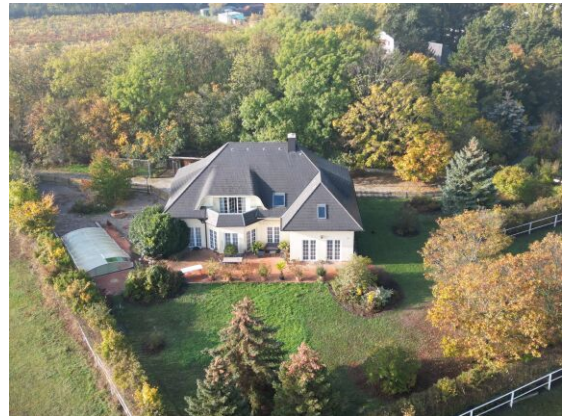
Wohnhaus von oben
